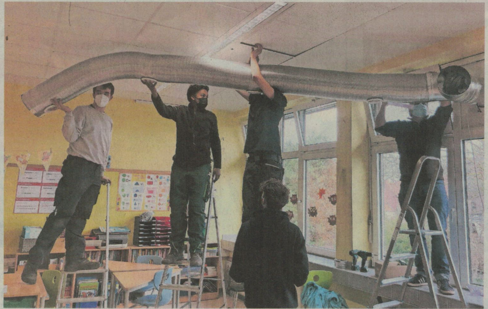
Die Schüler des Zehner-Technikkurses bei der Montage der Abluftanlage. Foto: Sekundarschule Grefrath
